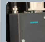
Modem Permite a ligação ao grupo através de PC, obtendo informação sobre o estado do mesmo. Em caso de avaria do equipamento, envia um SMS ao utilizador.
