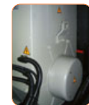
Ímã permanente no alternador (a partir de 100 kVA). Melhora a capacidade de arranque.
